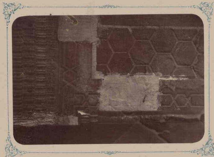
ЧАСТЬ ЦОКУЛЯ ВНУТРИ МАВЗОЛЕЯ.
